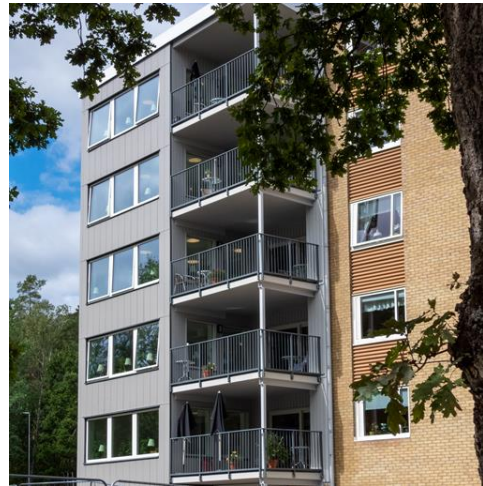
Källstorpsgården Vård- och omsorgsboende
