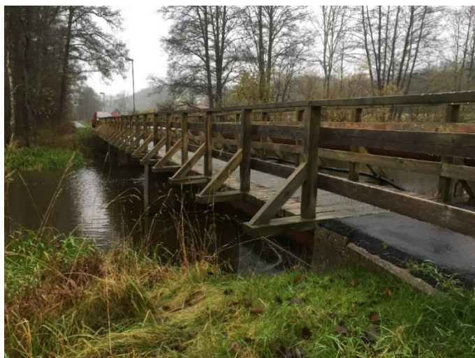
Bild 1. GC bro Slumpåvägen
