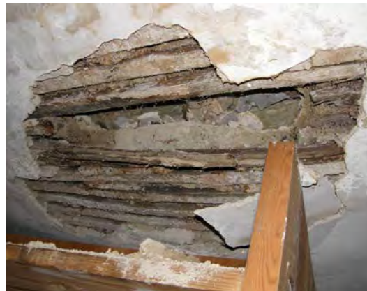
Fuktskada på skorstenen och tak som orsakat att puts fallit ned från innertaket på våning två.
