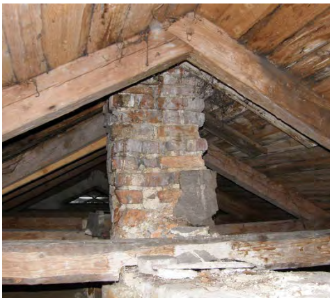
Fuktskada på skorstenen och tak som orsakat att puts fallit ned från innertaket på våning två.
