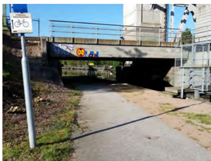
Tunnel vid järnvägsbrons östra brofäste
