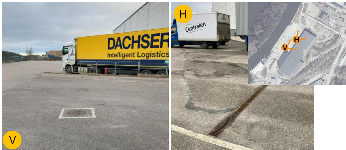
Figur 11: Vänster bild visar dagvattenbrunn med beteckning D400. Vänster bild visar ACO-dränledning som finns på flertal uppställningsplatser för lastbilar lägst med fasaden.
