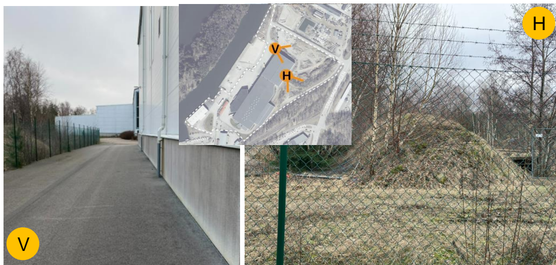
Figur 13: Vänster bild visar stuprör ner till marken. Höger bild visar naturmark och jordhög/kulle.
