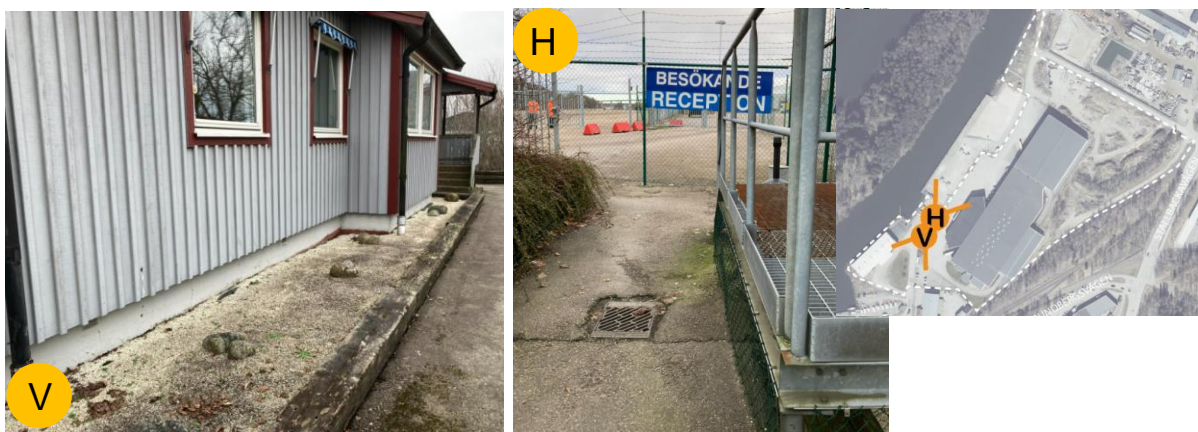
Figur 9: Vänster bild visar stuprör som går ner i marken. Höger bild visar rännstensbrunn.
