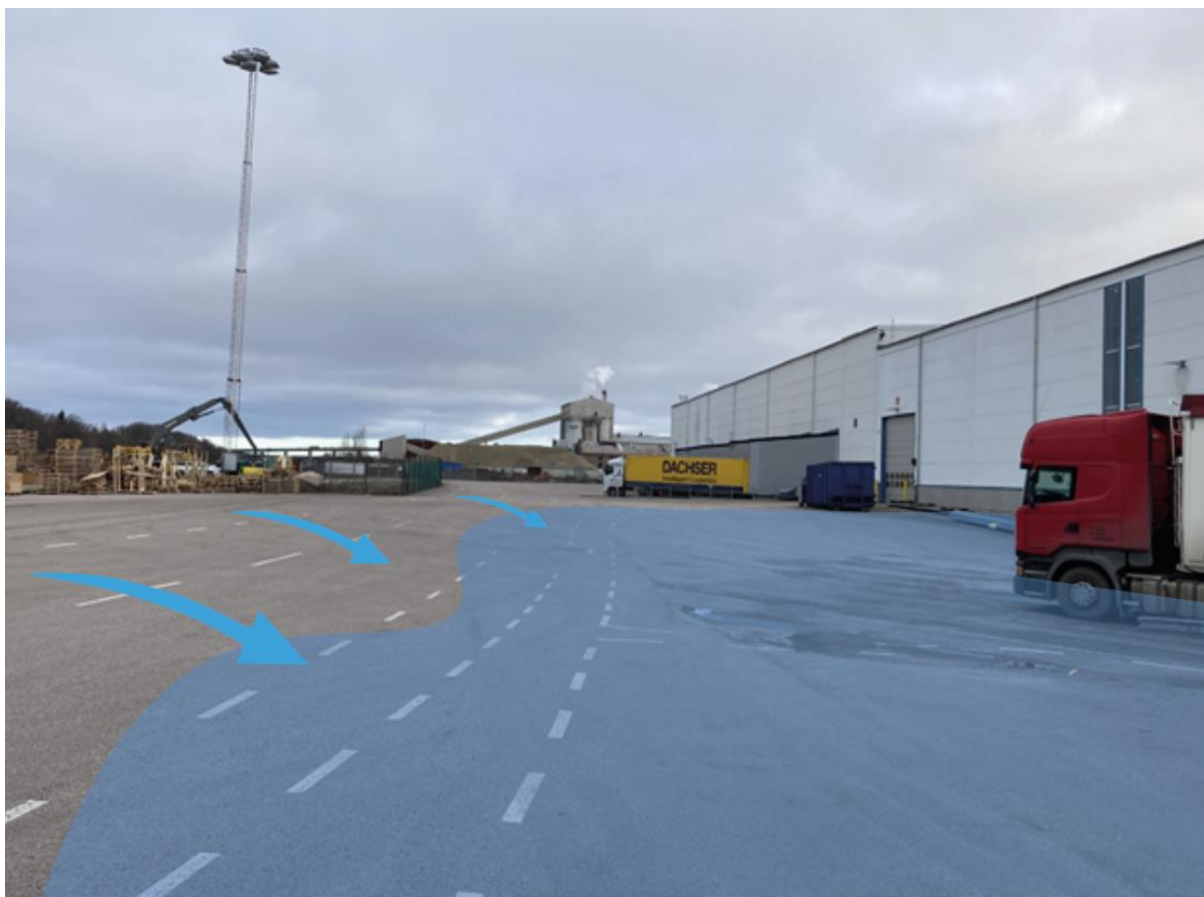
Figur 31: Illustration av befintlig torrdamm vid fyllt dagvattensystem.
