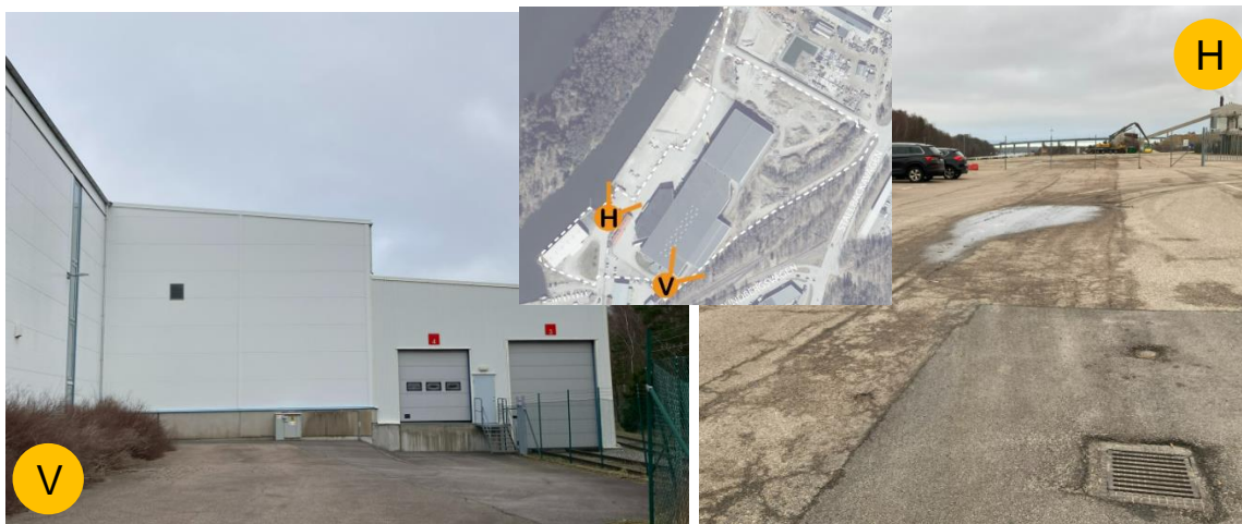
Figur 15: Vänster bild visar fasad med takavvattning via stuprör. Höger bild visar parkering vid hamn med rännstensbrunn.
