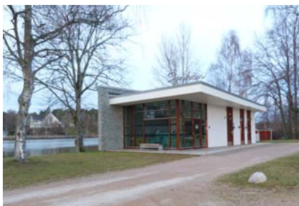
Gästhamnens nya servicebyggnad. (Foto Trollhättans Stad)
