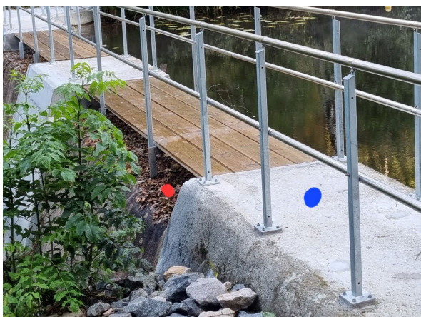
Figur 27. Dammen som reglerar sjön Trehörningen. Vattennivån i sjön kan som mest stiga till +56,51 meter vilket är nivån som markeras med blå prick. Bild tagen i september 2022 av samhällsbyggnadsförvaltningen.
