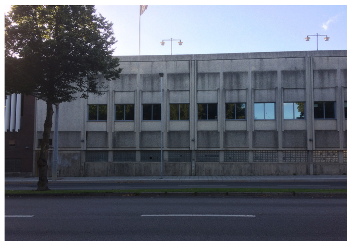
Bilderna till höger visar från ovan fasadmålning mot Magasinsgatan, betongfasaden mot Drottninggatan med dess varierade textur och strukturella indelning.
