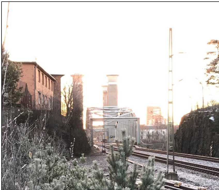
Figur 2-3. Bebyggelse närmast järnvägen till vänster. Norge-Vänerbanan till höger.
