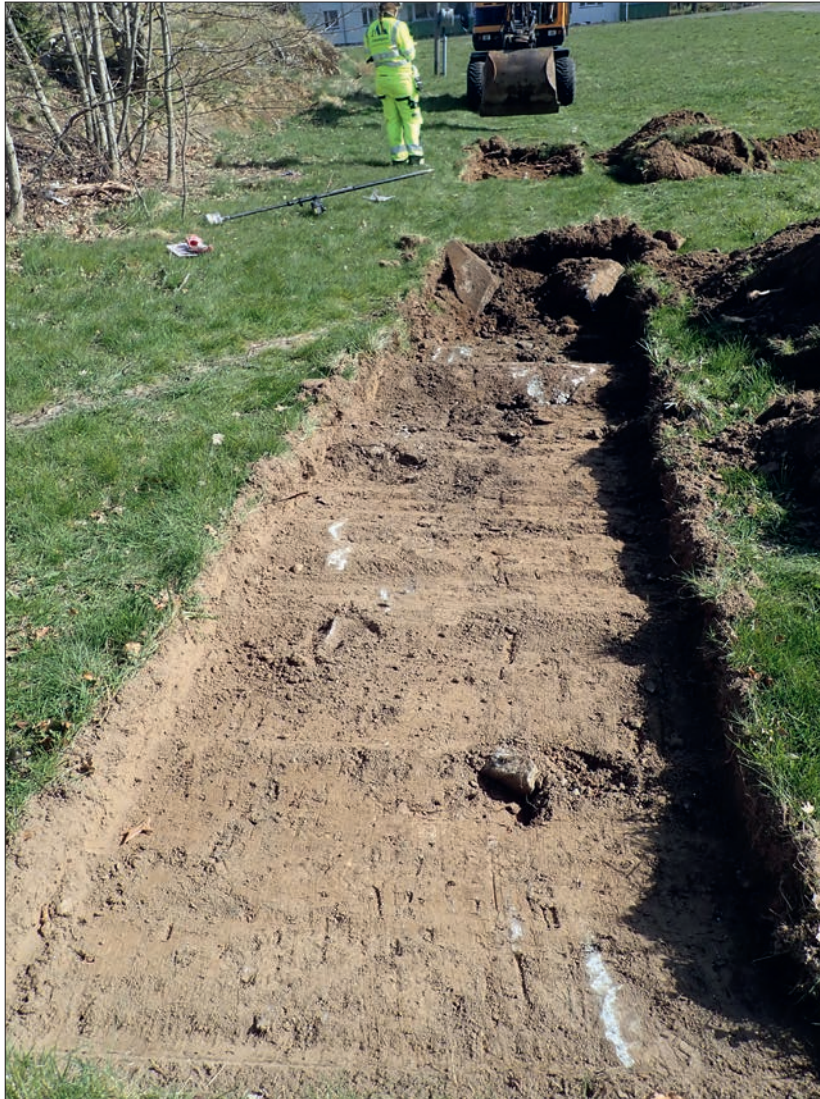
Figur 10. Gräsytan sydost om bergknallen var avschaktad och här fanns bara lerig sand med sten. Foto Christina Rosén.
