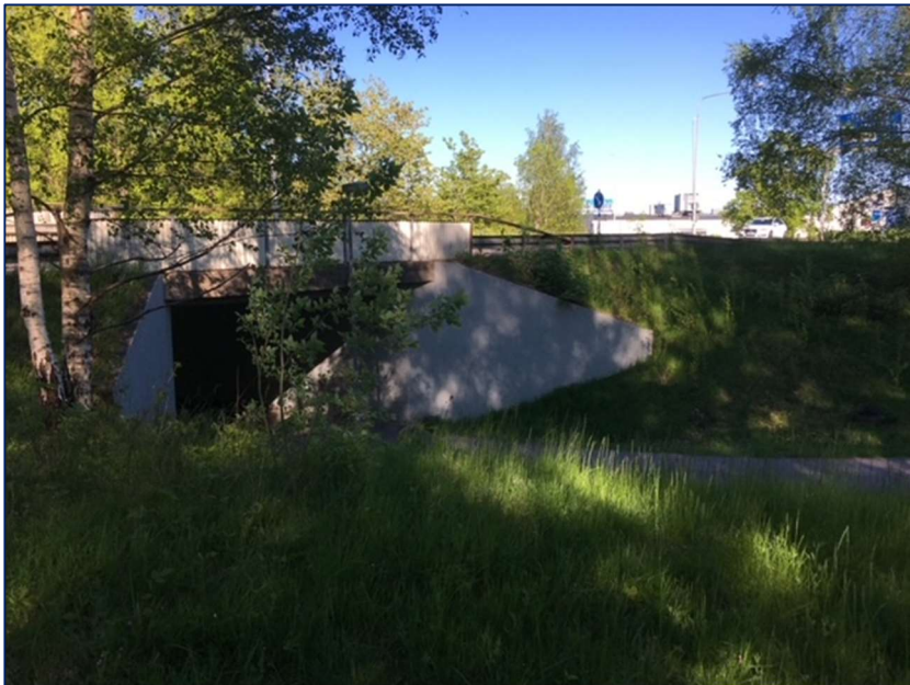
Figur 11. Viadukt som fungerar som passage under Kungssportsvägen för gång- och cykelvägen (Foto: Norconsult)
