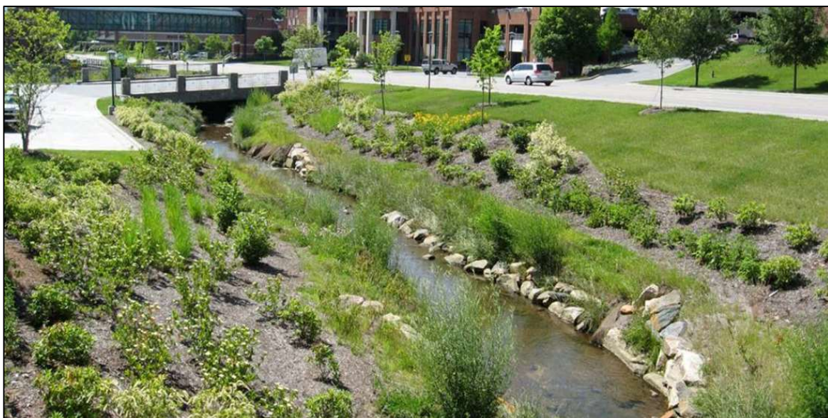
Figur 19. Exempel på ett vattenförande svackdike (Boone creek) men vegetation i slänterna (Foto: Appalachian State University).
