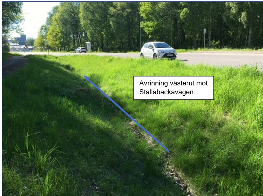
Figur 12. Avrinning mot dike utmed Kungssportsvägen.
