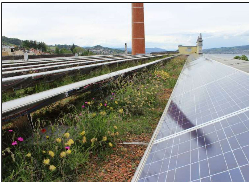
Figur 16. Kombination gröna tak och solceller (Källa: C/O City)
