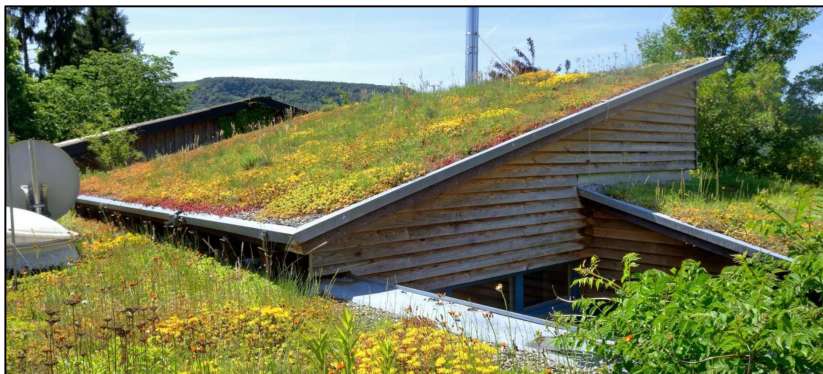
Figur 15. Grönt tak med lutande tak (Källa: Caneco)
