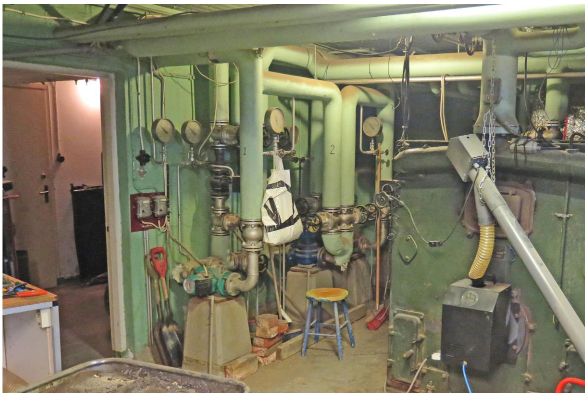
Pannrummet i källarvåningen. Foto: Lars Bergström
